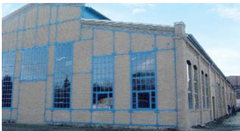
Sanierte Fassaden des neuen Gießereimodellbaus
