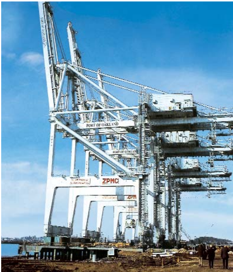
Von VEM-Motoren bewegt: Kräne im Hafen von Oakland (USA)
