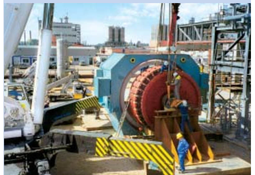
Der 160 Tonnen schwere Hauptkompressor-Antrieb wird mit Kränen an seinen Einsatzort befördert.
