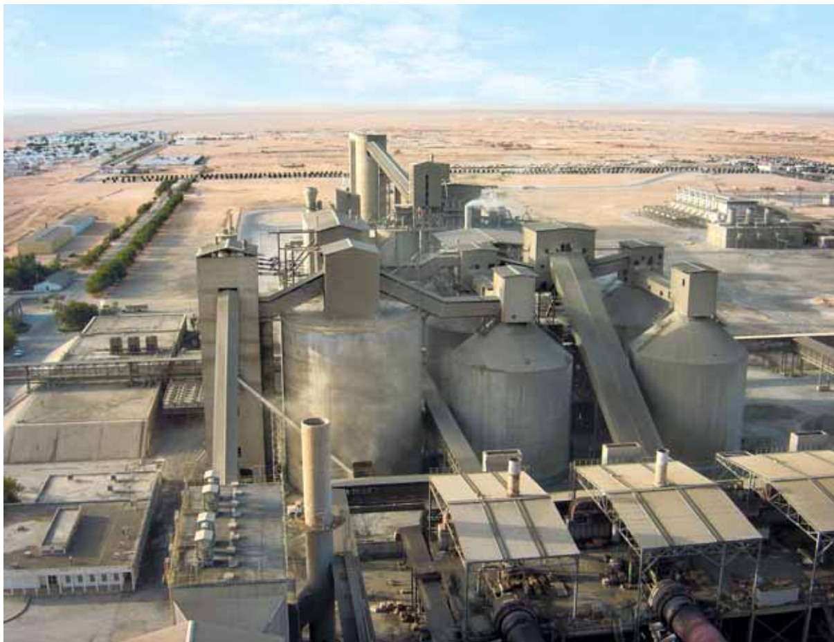
Zementwerk Rabigh der Arabian Cement Company. Für seine boomende Wirtschaft braucht Saudi-Arabien große Mengen an Zement. Die neue Produktionslinie im Zementwerk Rabigh ist für die Herstellung von rund 7.000 Tonnen Klinker pro Tag ausgelegt.
