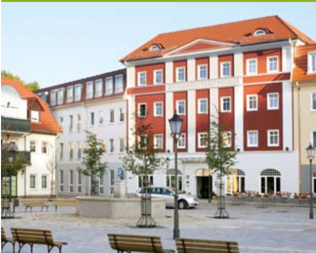
Der neu gestaltete Marktplatz in Bad Muskau
