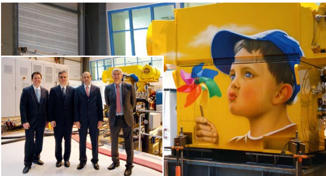
Kooperationspartner beim Systemtest. Das Team (v. l. n. r.): Markus Eichler und Jürgen Schmitz (Woodward), Stefan Kunkel und Gerhard Freymuth (VEM). Rechts der permanenterrregte Synchrongenerator
