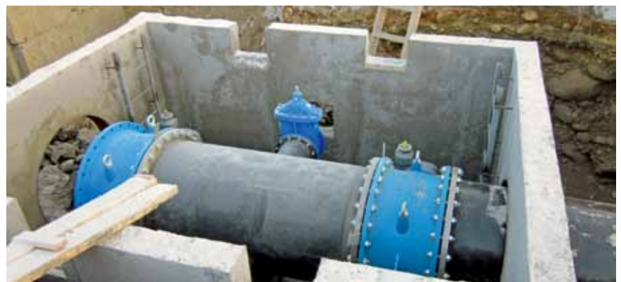
In arktischem Dauerfrostboden erfolgt das Verlegen von Rohren unter extremen Bedingungen.
