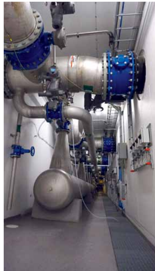
Installation der neuesten Generation von Absperrklappe und Antrieb/Steuerung in einem skandinavischen Wasserwerk
